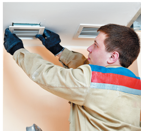
Montaż kratki wentylacyjnych w pomieszczeniu
