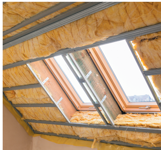
Ocieplenie dachu płytami wełny mineralnej
