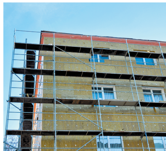
Ocieplenie ściany zewnętrznej z użyciem płyt wełny mineralnej
