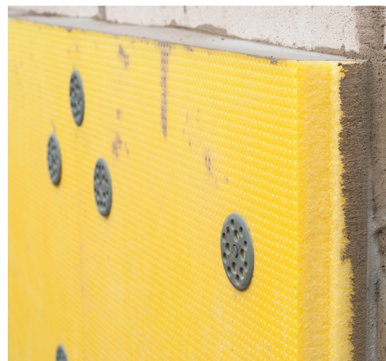
Ocieplenie ściany zewnętrznej z wykorzystaniem kołków montażowych
