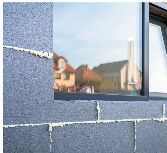
Ocieplenie ściany zewnętrznej styropianem grafitowym wykonywane według instrukcji ETICS
