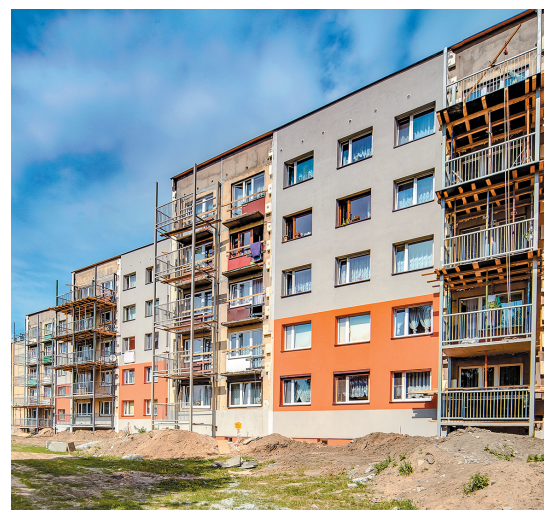
Ocieplenie ścian zewnętrznych budynku prowadzone zgodnie z instrukcją ETICS
