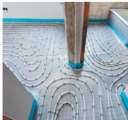
Ogrzewanie podłogowe przed wykonaniem posadzki
