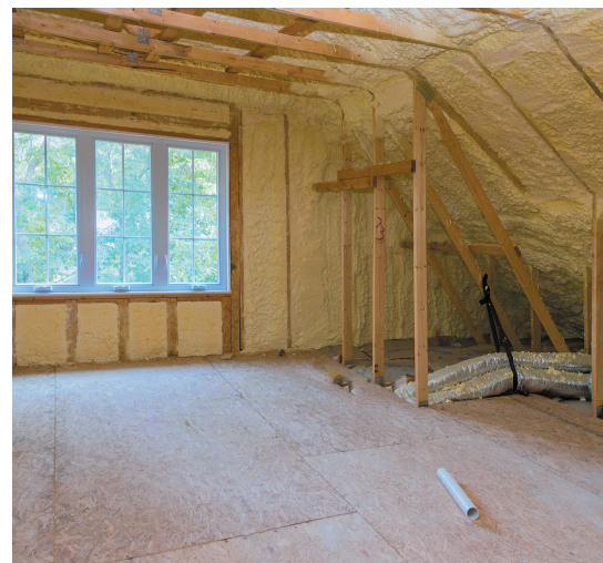
Ocieplenie dachu metodą natryskową między krokiewiami
