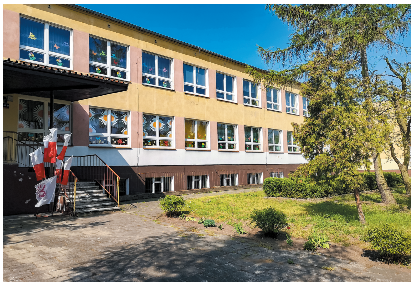
Budynek Szkoły Podstawowej w Bieganowie – stan przed termomodernizacją
